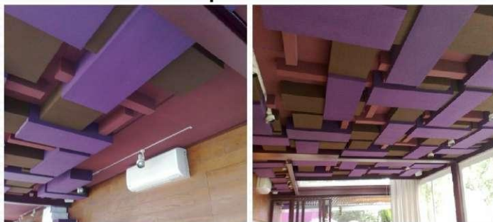
Forro Acústico para Restaurante em SP
